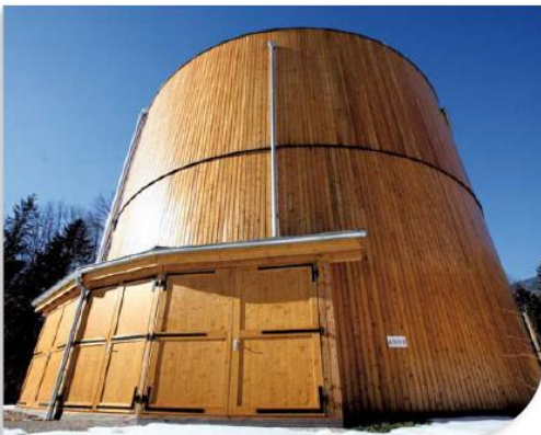
Silo de digestion des boues bardé de mélèze
